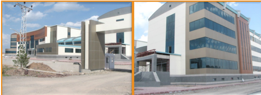
Resim 2.8 Kars Merkez Haydar Aliyev Endüstri Meslek Lisesi inşaatı
