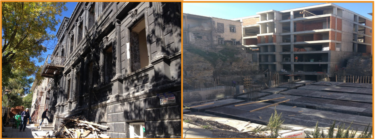
Resim 2.12 Belediye hizmet binası yapımı
